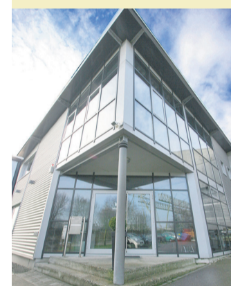
Eingang des PTS-Gebäudes.
