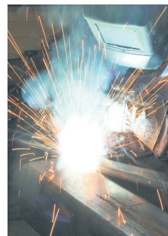
Schweißerarbeiten erledigt PTS.
